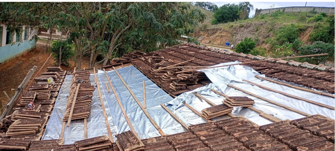
Escola Boaventura Abritta, em Cataguarino, recebe reforma completa do telhado
