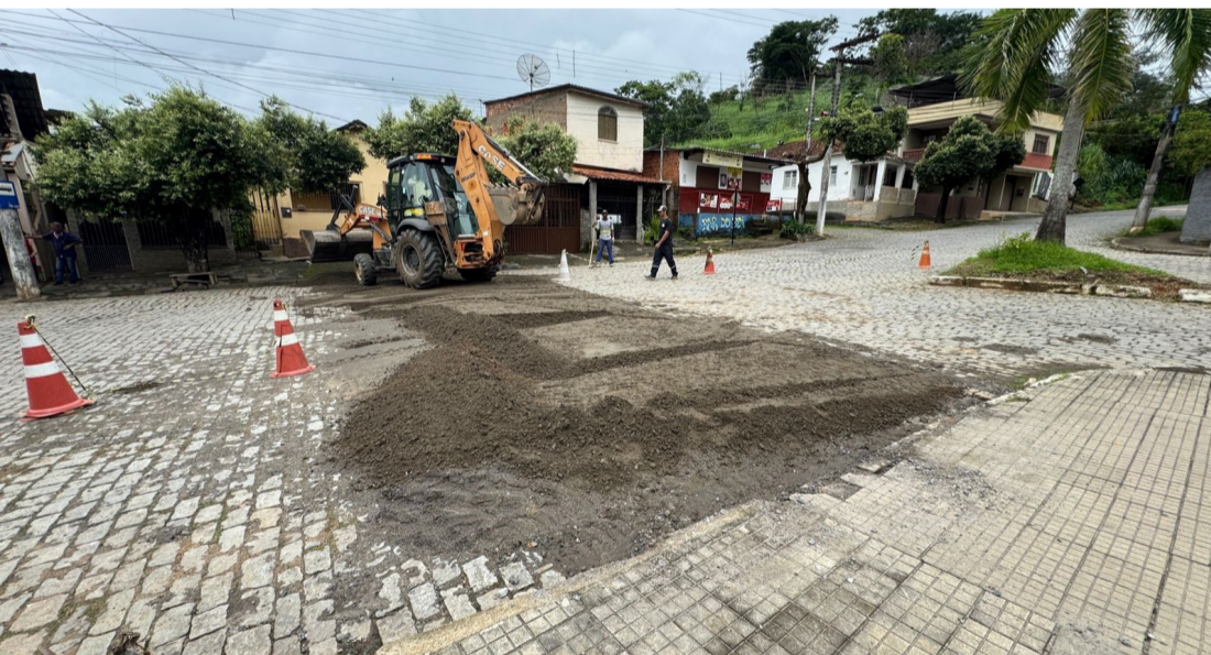
Preparo da base do piso da nova faixa de pedestre em frente à Escola Doutor Norberto, Bairro Granjaria
