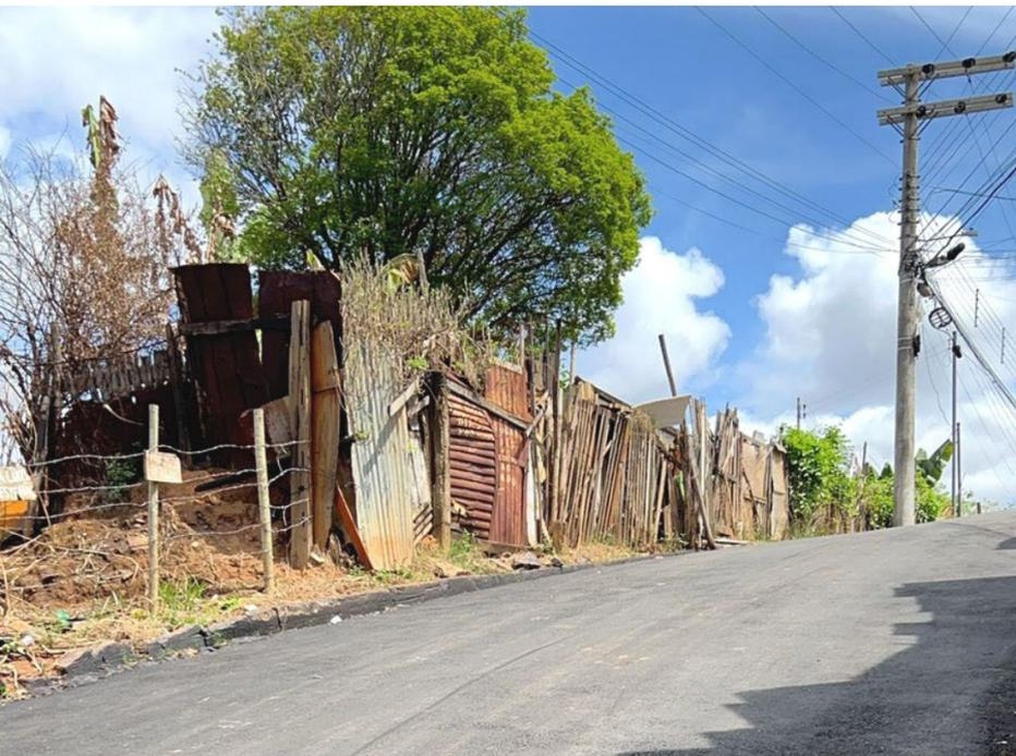
Na semana passada, foi concluído o asfaltamento da Rua Aquiles Fialho, no Bairro Pouso Alegre, até então calçada em pedra fincada. A nova pavimentação é em asfalto quente (CBUQ) medindo sete centímetros de espessura, o que garante mais durabilidade, reduzindo a necessidade de manutenção constante.
