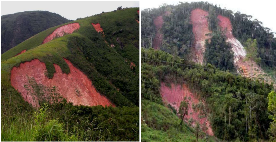
Figura 108 – Exemplos de Processos de Erosão do Tipo Desprendimento e Escorregamento
