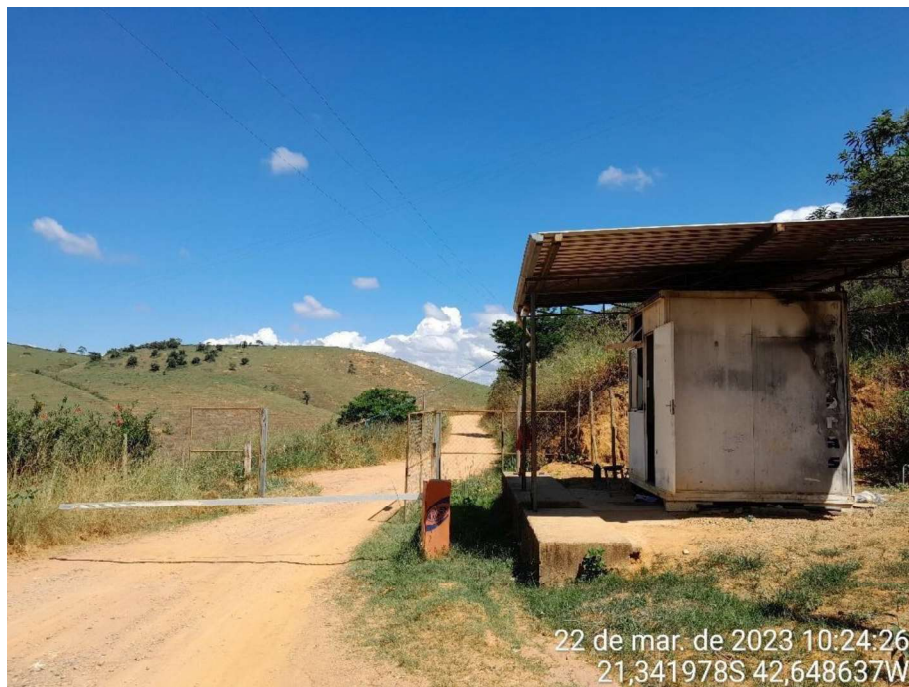
Figura 102 – Guarita de Acesso ao Aterro Atual
