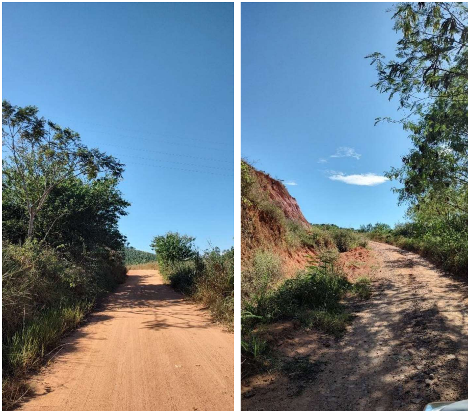
Figura 100 – Estrada de acesso ao aterro
