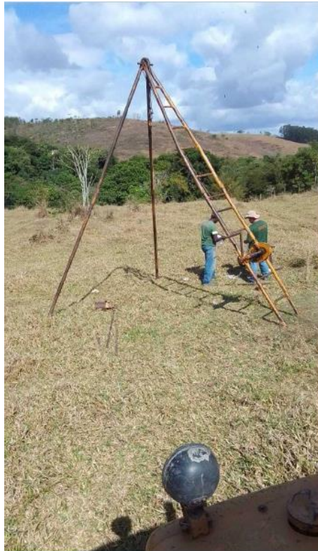
Figura 42 – Registro Fotográfico do Ensaio de Sondagem SPT-07
