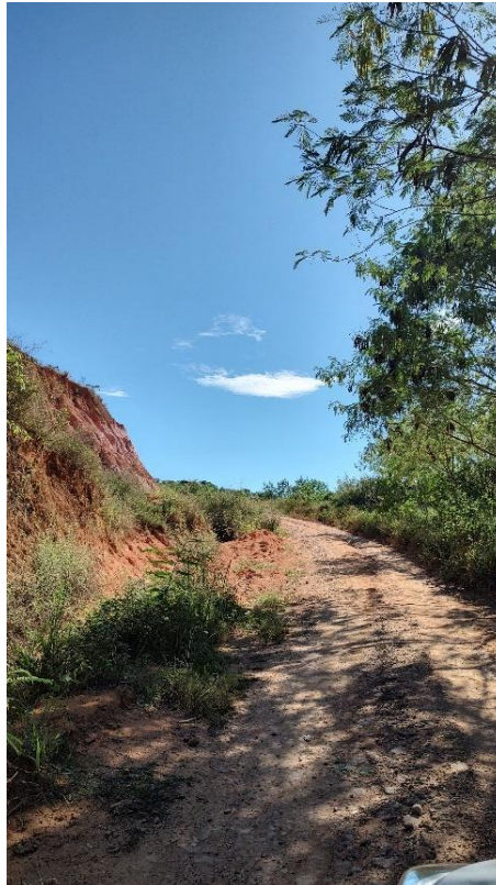
Figura 123 – Estrada de acesso ao aterro
