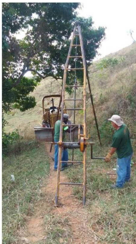
Figura 41 – Registro Fotográfico do Ensaio de Sondagem SPT-06
