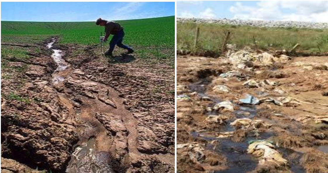
Figura 130 – Exemplos de Processos de Erosão do Tipo Laminar
