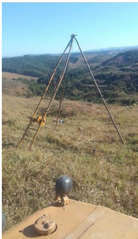
Figura 39 – Registro Fotográfico do Ensaio de Sondagem SPT-04
