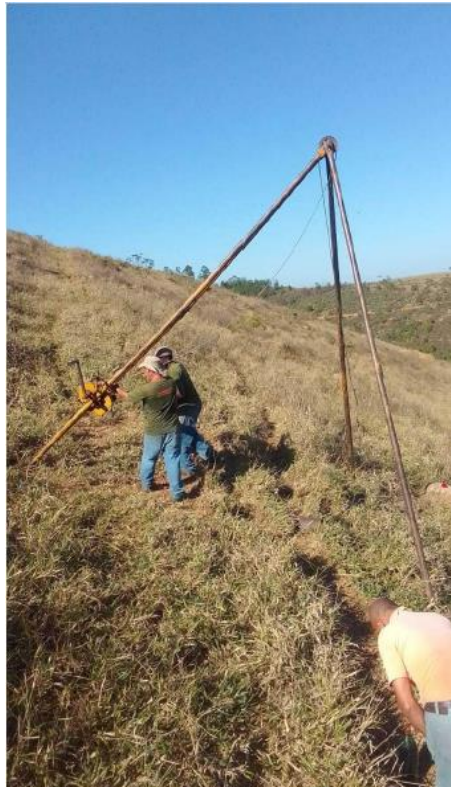
Figura 40 – Registro Fotográfico do Ensaio de Sondagem SPT-05
