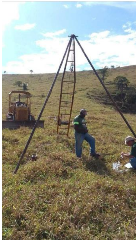
Figura 38 – Registro Fotográfico do Ensaio de Sondagem SPT-03
