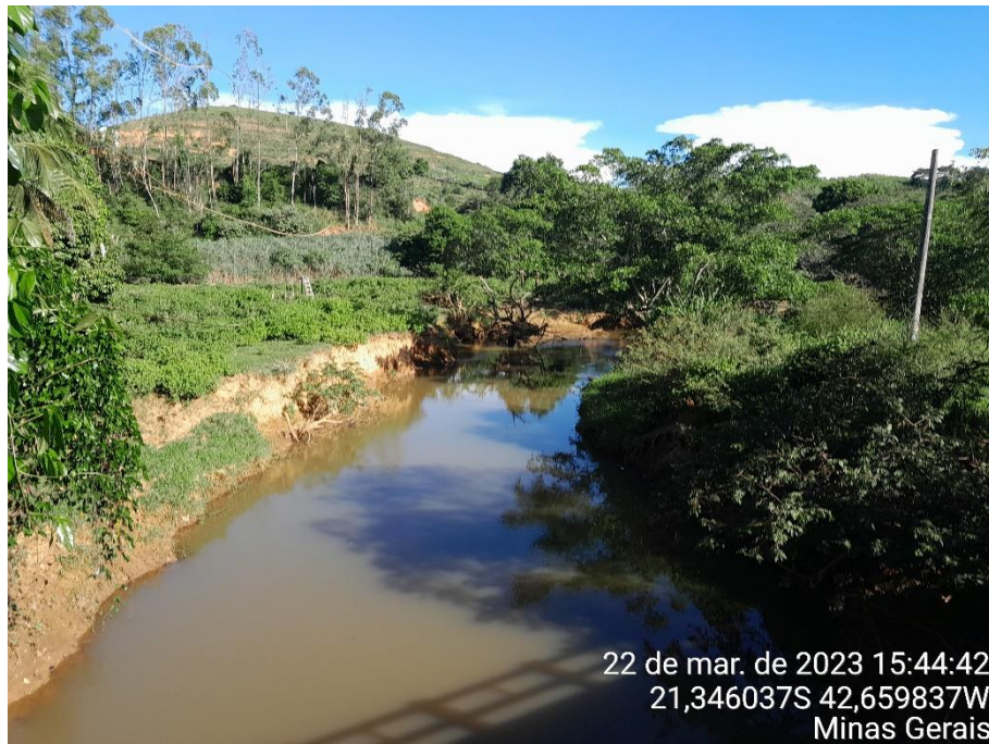
Figura 126 – Corpo Hídrico Receptor dos Efluentes, a Jusante do Ponto de Lançamento
