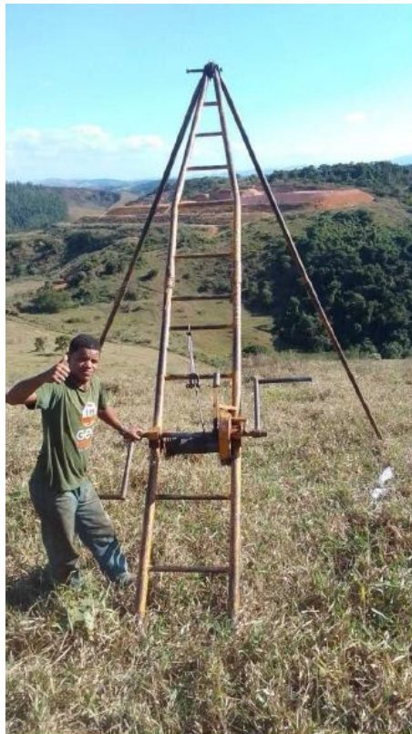
Figura 36 – Registro Fotográfico do Ensaio de Sondagem SPT-01
