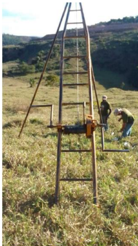
Figura 37 – Registro Fotográfico do Ensaio de Sondagem SPT-02
