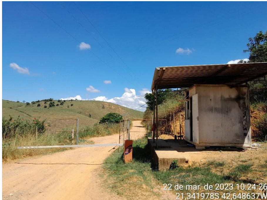
Figura 125 – Guarita de Acesso ao Aterro Atual
