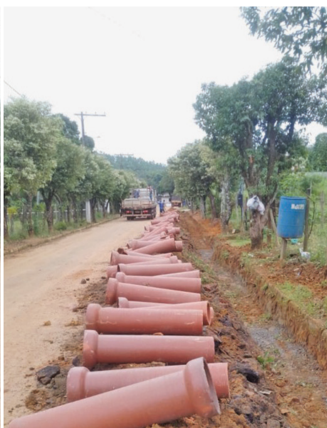
Distrito de Cataguarino - Nova rede de esgoto medindo 100 metros de extensão
