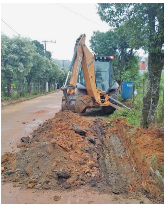
Distrito de Cataguarino - Nova rede de esgoto medindo 100 metros de extensão
