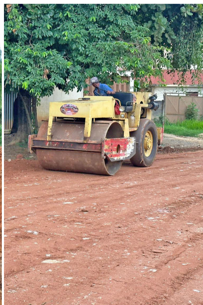
Vila Tâmega - Preparação para asfaltamento
