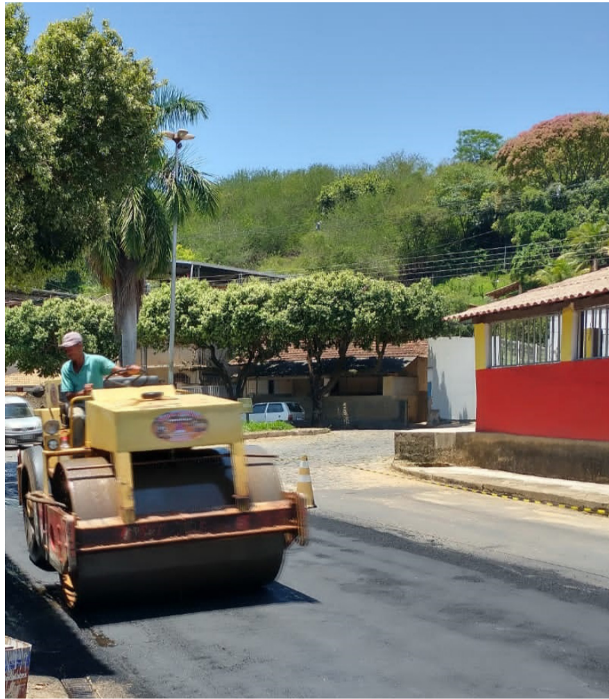
Bairro Popular - Asfalto na Rua Antero Ribeiro
