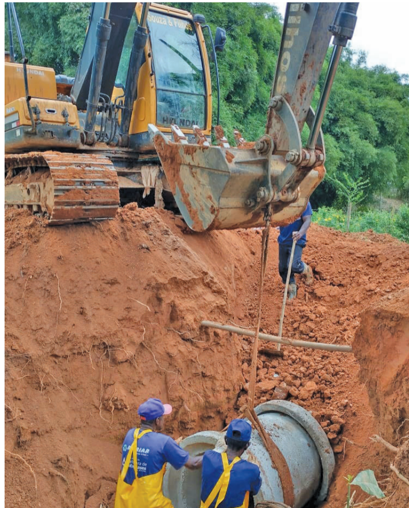
Estrada Marote a Cachoeirinha - Rede pluvial
