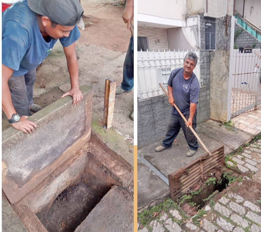
Foram retomados os serviços de limpeza de bueiros. Depois do trabalho executado em todo o Bairro Leonardo, as tarefas avançaram em duas frentes. Uma delas na Rua Luiz Pinto da Silva, devendo perfazer toda a Vila Minalda. Outra equipe vem realizando as mesmas ações pelas ruas do Bairro Taquara Preta. O objetivo é facilitar a vazão das águas, evitando obstruções e alagamentos neste início do período chuvoso.
