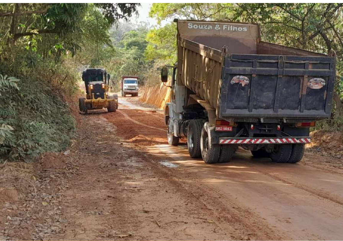
Estrada Aracati - Vista Alegre: manutenção com saibro
