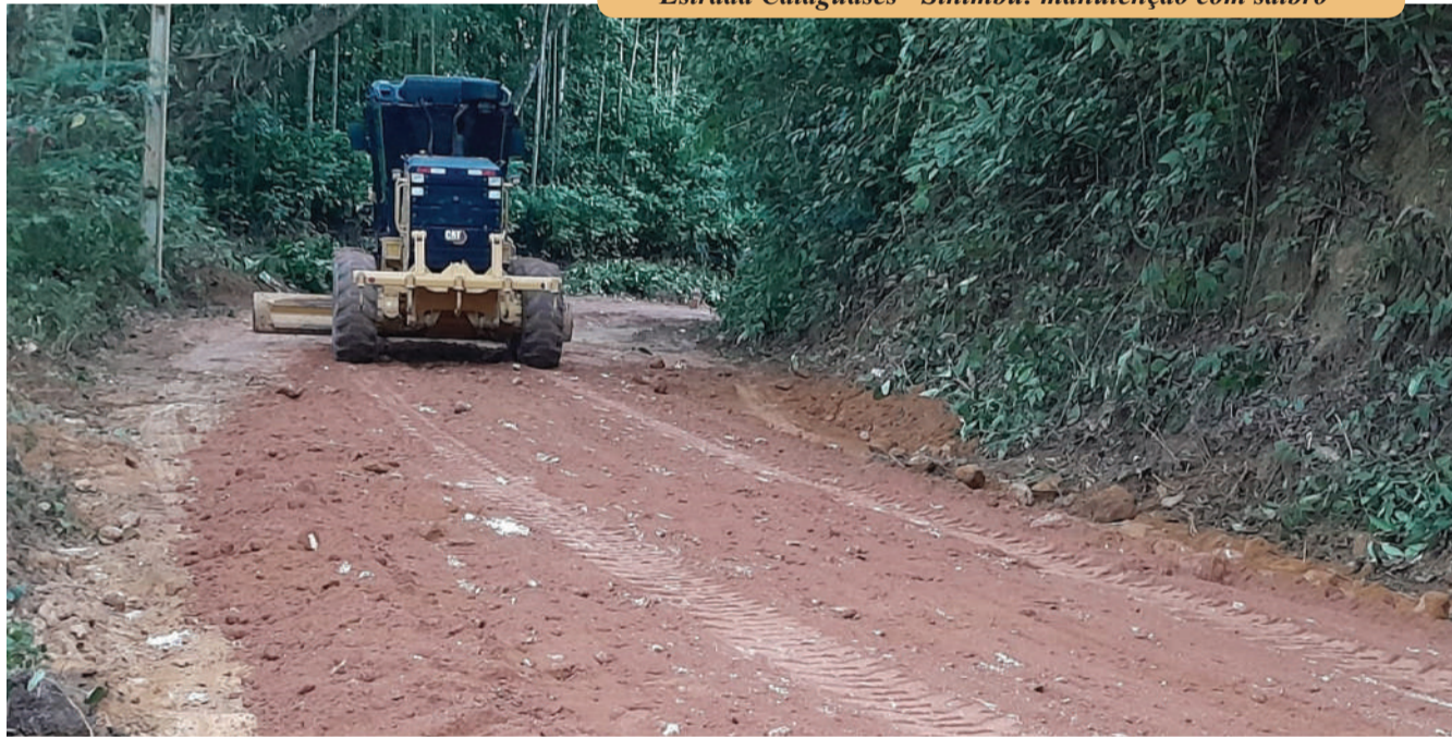
Estrada Cataguases - Sinimbu: manutenção com saibro
