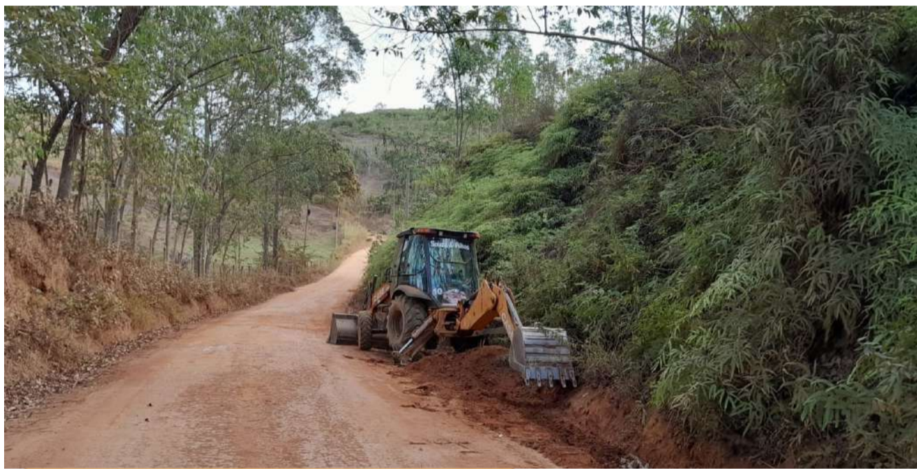
Estrada Cataguases - Cataguarino limpeza de valetas e bueiros
