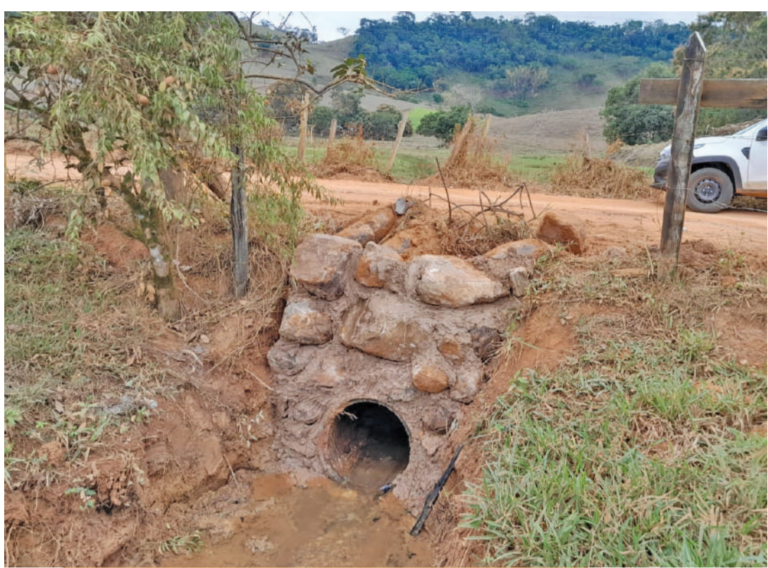
Estrada Cataguarino - Cataguases: serviço de drenagem pluvial
