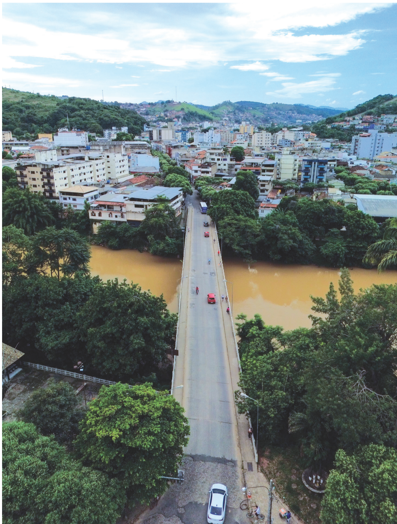
Popularmente conhecida como Ponte Nova (oficialmente Ponte Astolfo Dutra Nicácio Neto), a ponte construída no início dos anos 50 do século passado, será pela primeira vez devidamente reformada
