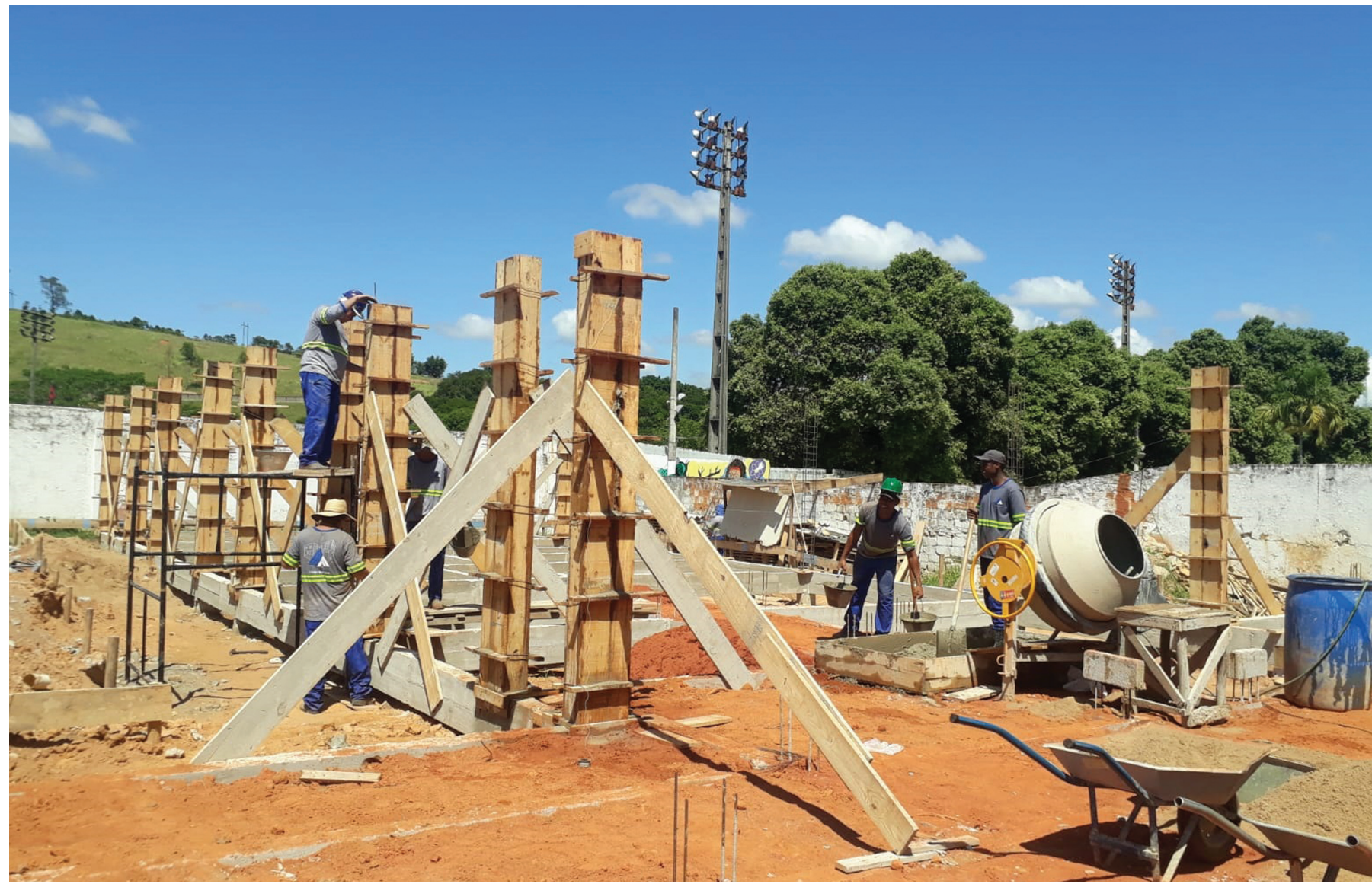
Em breve, a PM terá um espaço moderno e adequado para continuar protegendo a população com excelência!
