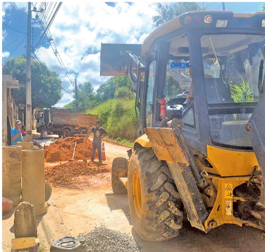
Uma importante obra de drenagem vem sendo realizada no Bairro São Diniz, para afastar riscos de novos deslizamentos de encostas
