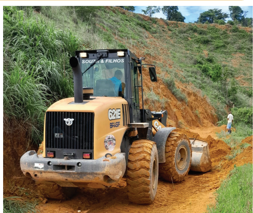
Na estrada que liga a Fazenda dos Moura à comunidade Itapira, próximo ao Distrito de Sereno, também foram liberados todos os trechos obstruídos por deslizamentos de encostas
