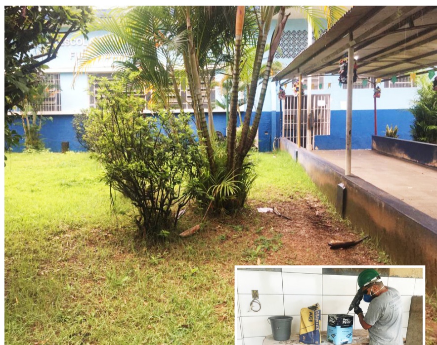
Colocação de cerâmica na Escola Municipal Flávia Dutra (Vila Tereza)
