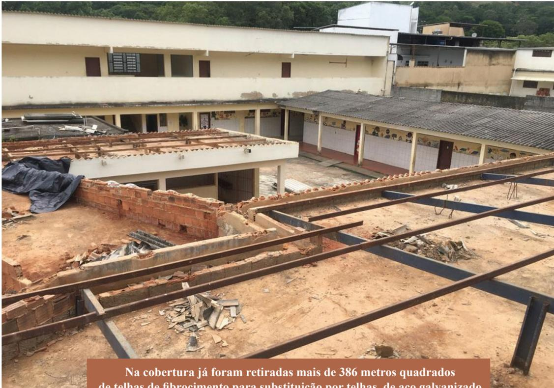
Na cobertura já foram retiradas mais de 386 metros quadrados de telhas de fibrocimento para substituição por telhas de aço galvanizado
