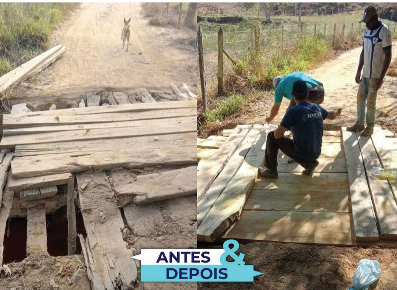
Recuperação da ponte da Fazenda da Aldeia - Distrito da Glória
