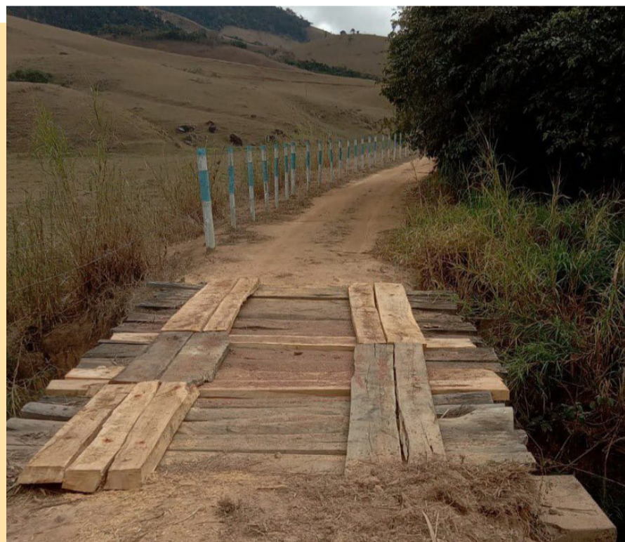
Recuperação da ponte da Roseira - Distrito da Glória
