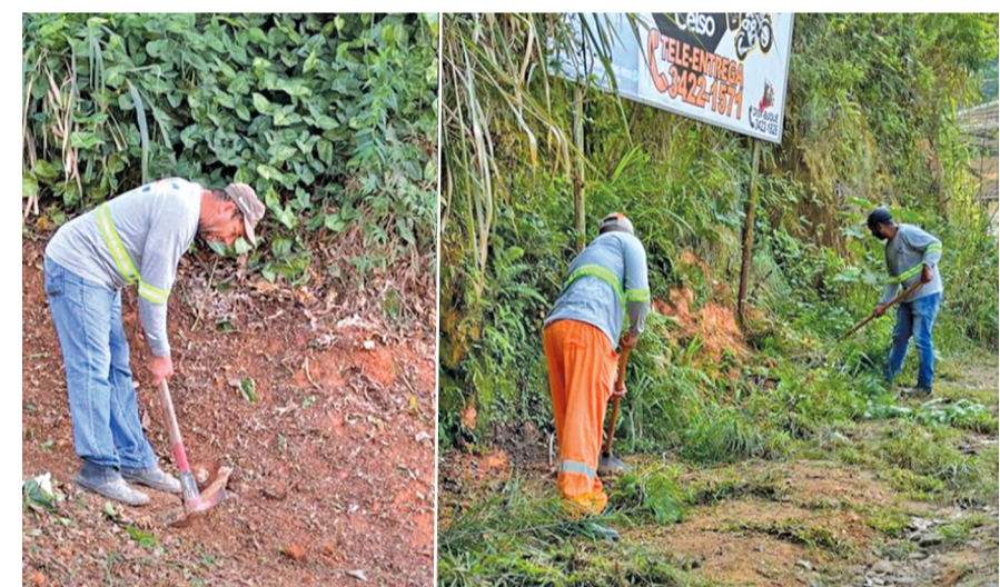
Limpeza da Rua Nossa Senhora das Dores, no trecho que será reurbanizado
