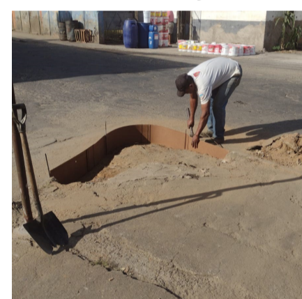
Manutenção de meio-fio na esquina das ruas Dr. Norberto Custódio Ferreira e Joaquim Augusto de Almeida
